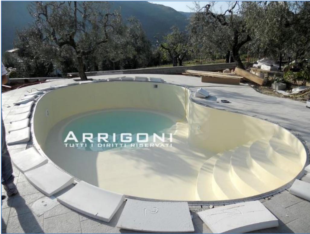
Foto scattata durante la posa della membrana in PVC su piscina costruita nei pressi di Rieti
