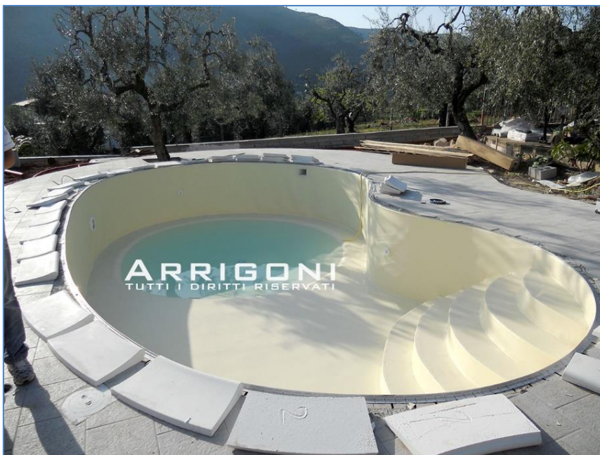
Foto scattata durante la posa della membrana in PVC su piscina costruita nei pressi di Rieti
